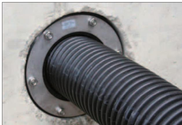
Abb. 2: Ringraumdichtung montiert
