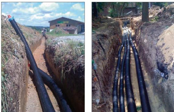
Laden Sie die Ringbunde dort ab, wo der Abrollvorgang beginnen soll. Fixieren Sie das freie Rohrende am Boden (z. B. mittels Sandsack) und rollen Sie das Rohr neben dem Graben ab. Bei den Mantelrohrdimensionen 90-125 mm empfehlen wir, die Kupplungsmontage neben dem Graben durchzuführen, bevor Sie die Rohrleitung in das Sandbett einlegen.
